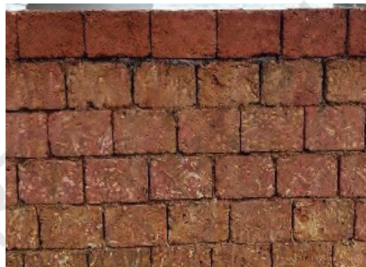
चित्र 11.7— ईंट बनाने के लिए लेटराइट का उपयोग
